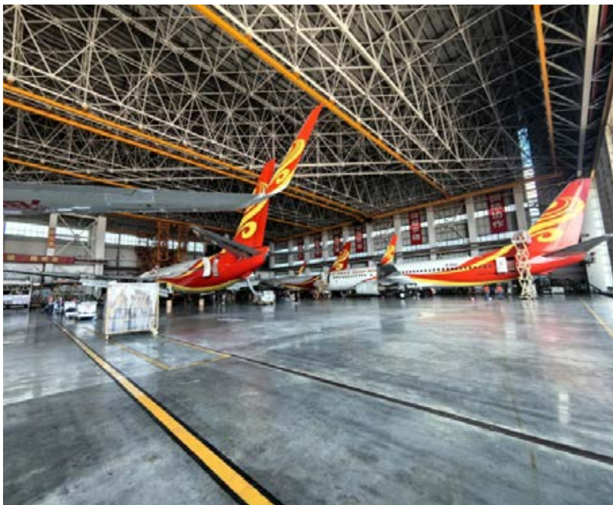
图 18 - 海南海口空港综合保税区“一站式”飞机维修基地
